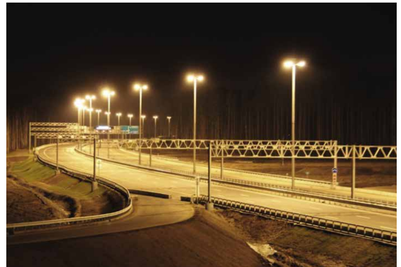
г. Санкт-Петербург, участок КАД
