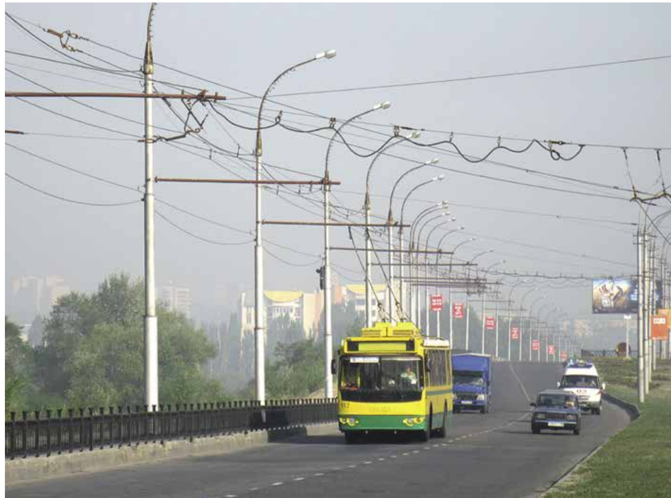
г. Липецк, Петровский мост
