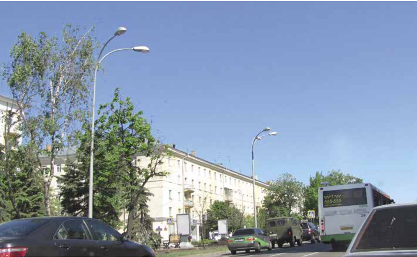
г. Ульяновск, освещение дороги
