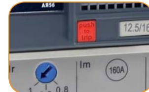
Возможность регулировки теплового расцепителя
