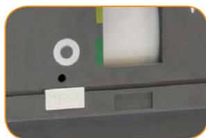
Проверка работоспособности автоматического выключателя кнопкой «ТЕСТ»
